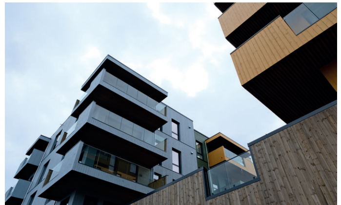
Balkongene ble levert ferdige med rekkverk, og kunne heises rett på plass under byggeprosessen.
