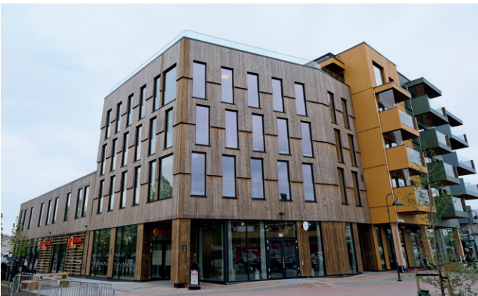
Det er synlig tre både på innsiden og utsiden av bygget.
